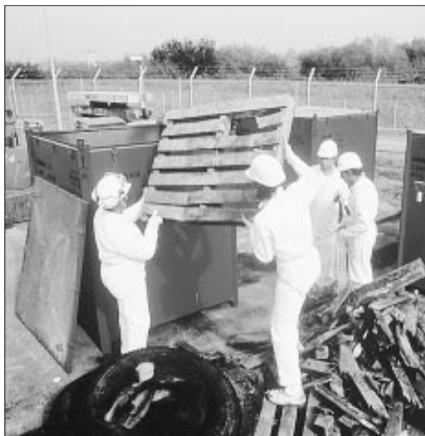
Sur le site seront stockés des gravats, ferrailles, comme ici des palettes de bois contaminées issues du démantèlement de la centrale de Brennilis (Finistère). (Médiathèque EDF/A. Gonin)
